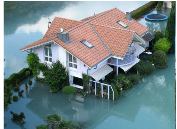
Hochwasserschaden bei Interlaken, August 2005 Quelle: Abteilung Naturgefahren Kt. Bern
